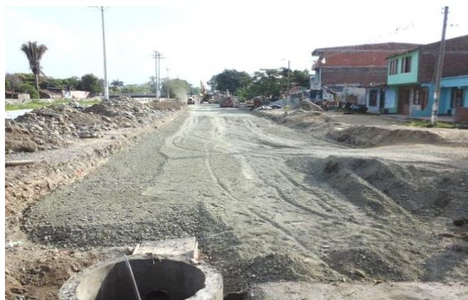
Alcantarillado Simón Bolívar
